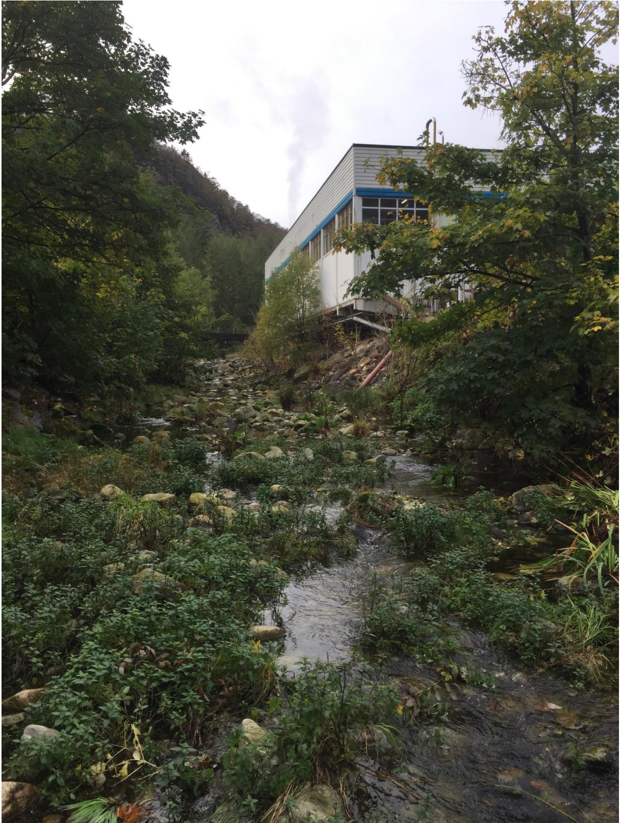
Figur 2. Foto som viser fabrikkbygningen sett fra nord.
