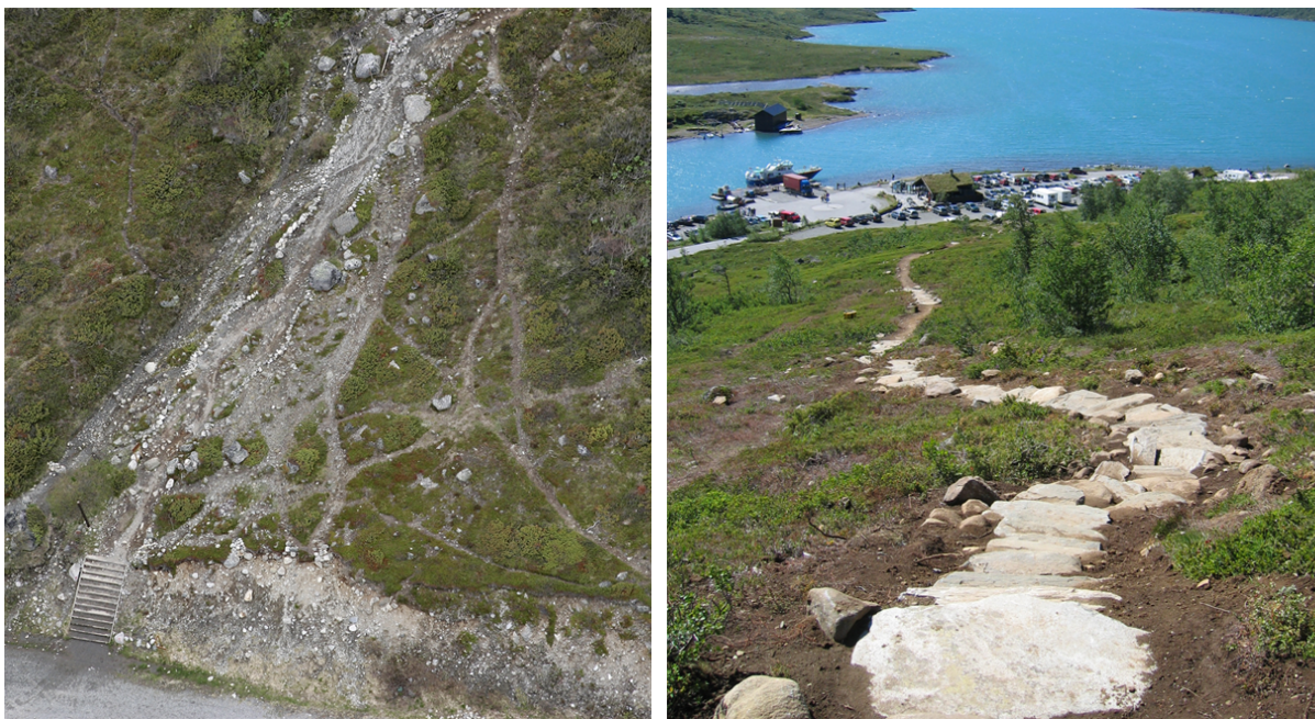
Tiltak på stiar med stor ferdsel og slitasje. Erosjon (til venstre) og utførte erosjonssikringstiltak (til høgre) på stien til Besseggen fra Gjendesheim i Vågå. Foto: SNO/Harald Klæbo.
