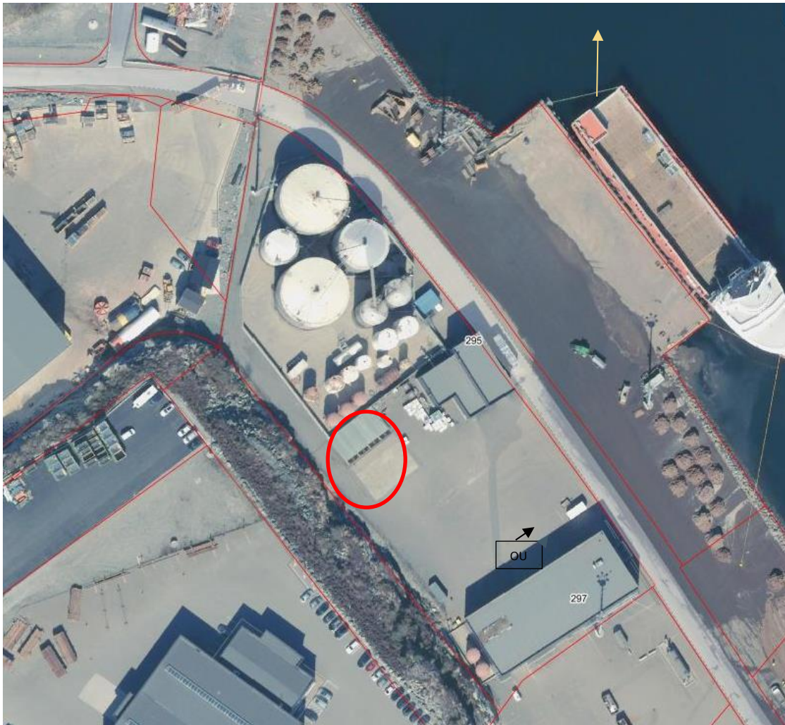
Figur 1: Bilde av tankanlegget med kai og nærmeste omgivelser samt eiendomsgrenser. Pil retning N. Plassering av laguner med tilhørende betongplate er angitt med rød ring.
