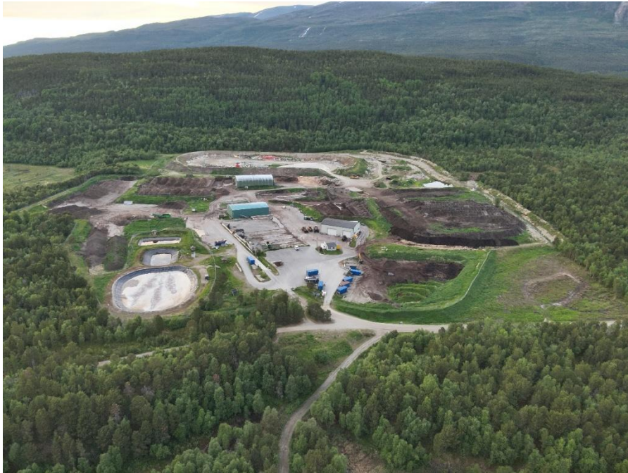
Figur 3: Dronefoto fra 2024 over anlegget.
