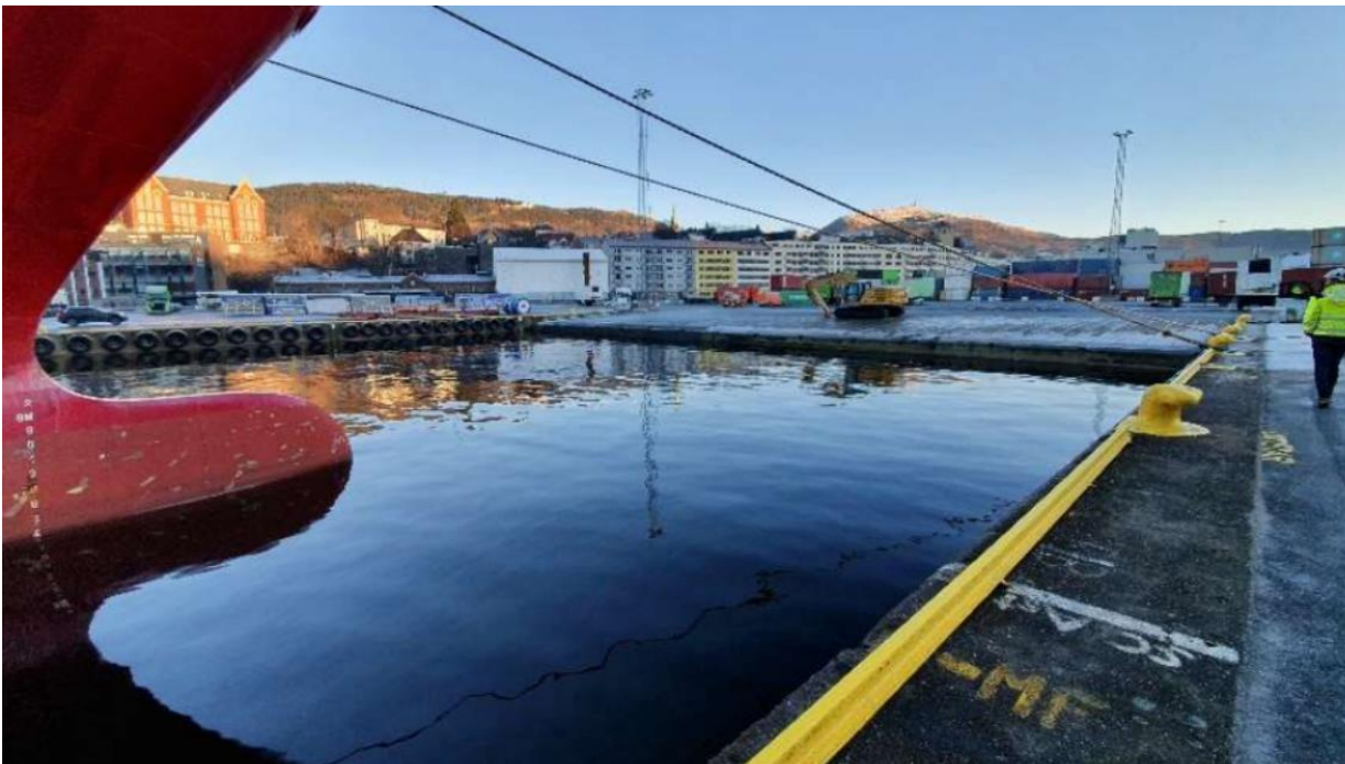
Figur 3-1 Dagens Ro-Ro-rampe innerst i Jekteviken [1].
