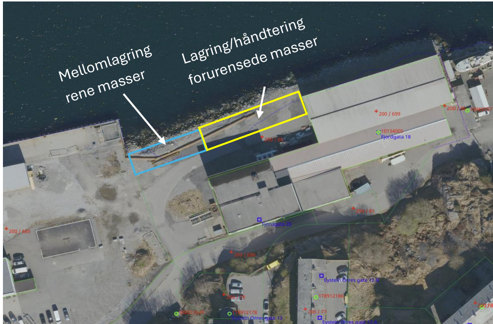
Figur 4: Flyfoto over området som er planlagt utnyttet som mellomlager. Massene legges i god avstand fra sjø. Kilde: norgebilder.no. Det er grusdekke over sprengsetinfylling.
