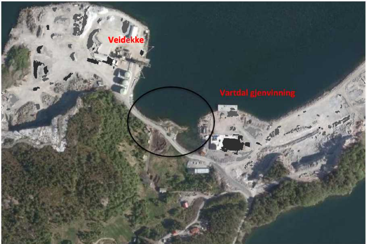
Figur 2 Flyfoto over deler av Husøya. Området hvor det skal fylles ut og bygges kai er markert med sort sirkel. (kilde: kart.statkart.no).
