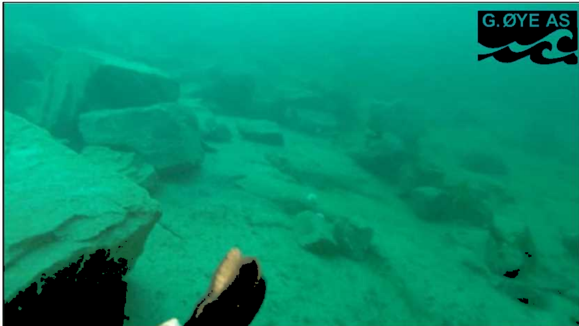
Figur 5 Sjøbunn ved prøvepunkt 1. Bildet viser fyllingsfoten, med grov blokk til venstre i bildet. Sjøbunnen i dette området består hovedsakelig av fjell med et tynt dekke av sedimenter.
