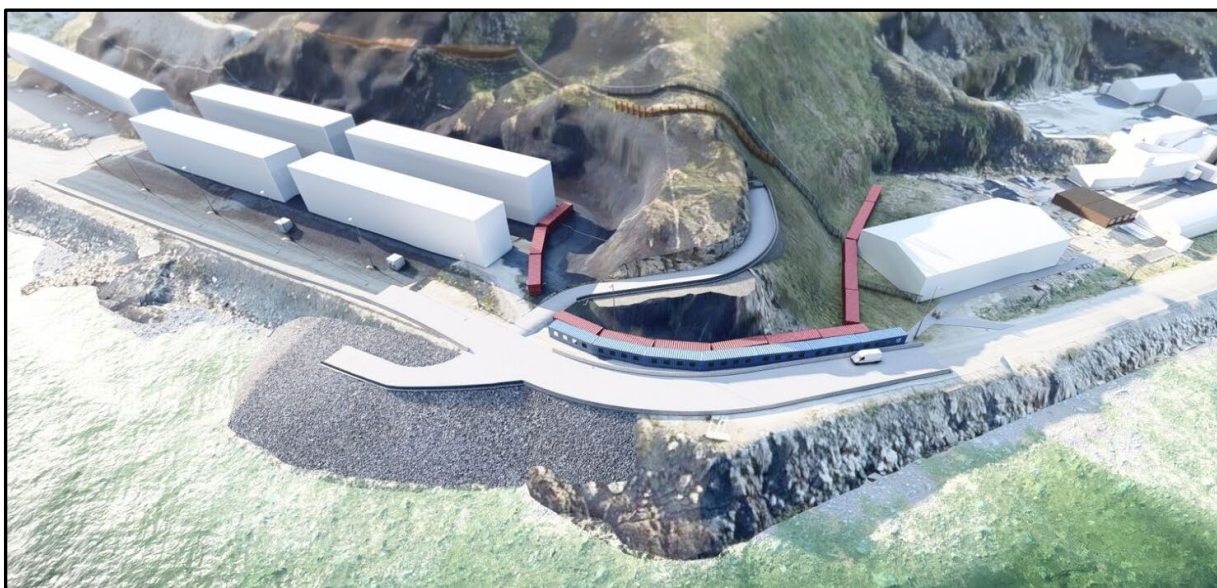
Figur 4-15 Anleggsvei vest for riksvei 94 langs fyllingen og trase for kryssende anleggstrafikk
