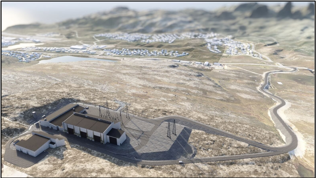
Figur 4-6 Hyggevatn etter ferdigstillelse med graveskråning, flomvannsgrofter og ventilasjonssjakter sett fra sørøst
