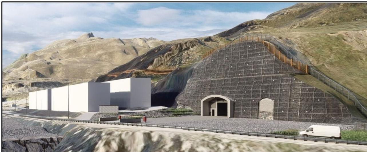
Figur 4-23 Illustrasjon av sikringsgjerdet - støttevegg (songemur) og reingjerdet som er flyttet
