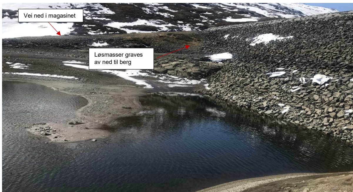
Figur 3 Oversikt over oppstrøms side av dam ved lav magasinvannstand.
