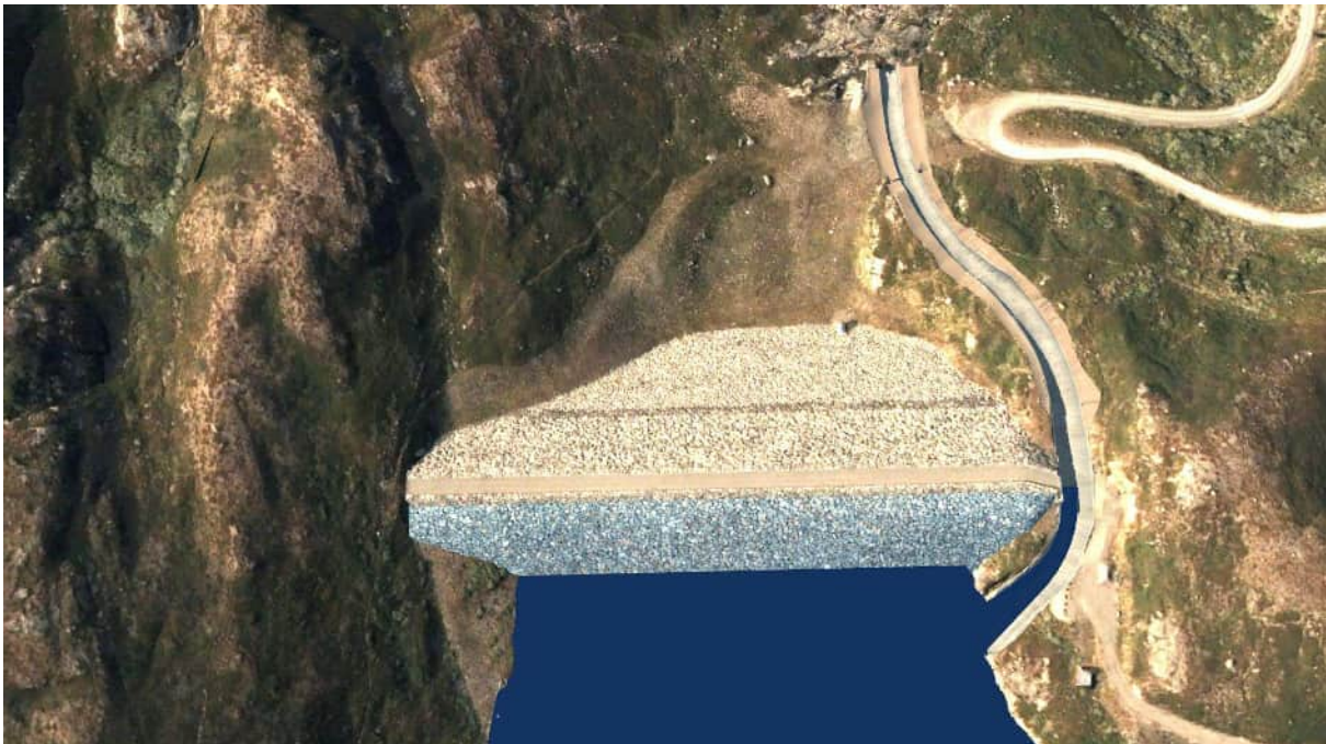
Figur 5 Modell av ny rehabilitert dam.
