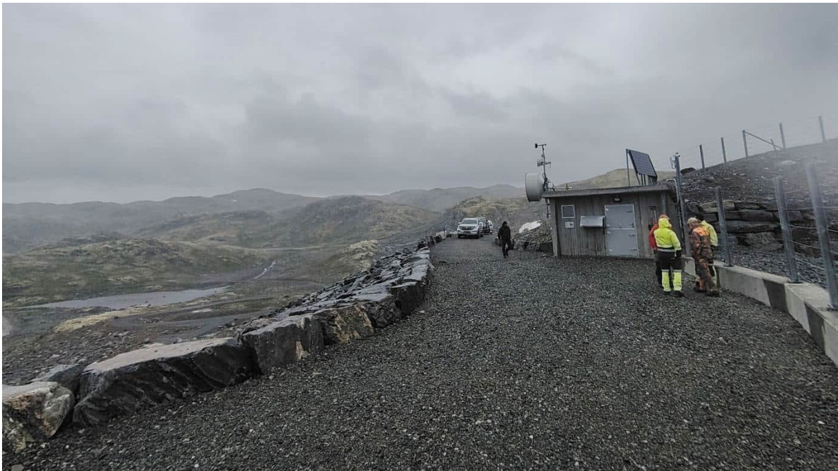
Figur 3-2 Befaring på damkrona ved Kvevatnet.
