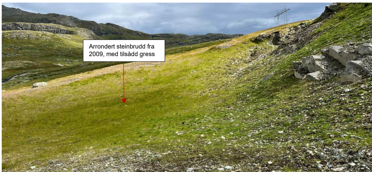
Figur 2-5: Bildet viser arrondert steinbrudd fra 2009. Gressarten som ble sådd ved istandsettingen skiller seg noe ut fra øvrig vegetasjon på høyfjellet.
