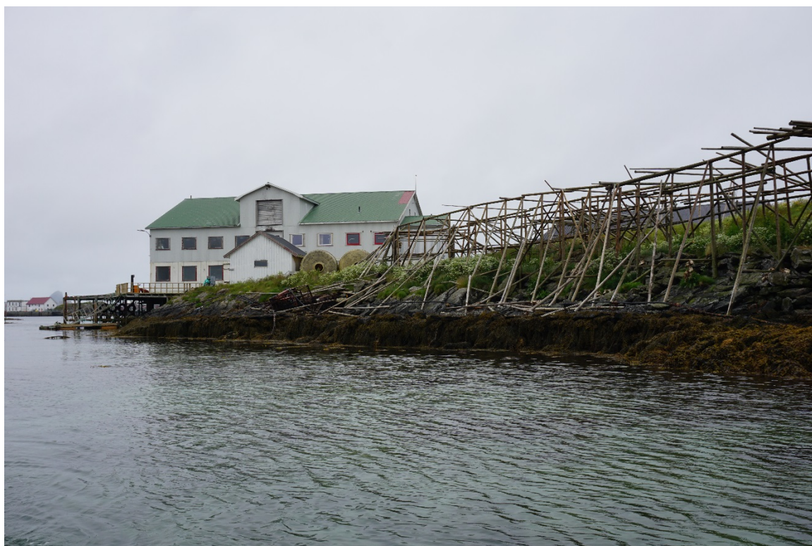
Figur 6. Planområdet på vestsiden av Prestholmen (mot nø).
