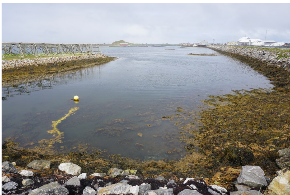
Figur 5. Tiltaksområdet sett fra Littl-Glea ved Gleaveien mot nordøst.
