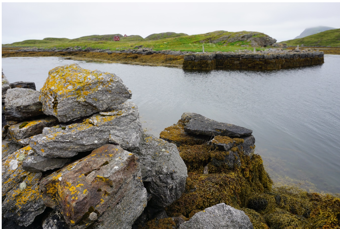
Figur 16. Steinkaier / bryggefundamenter i område 4 på holmer ved sørvest Lyngvær (mot s).
