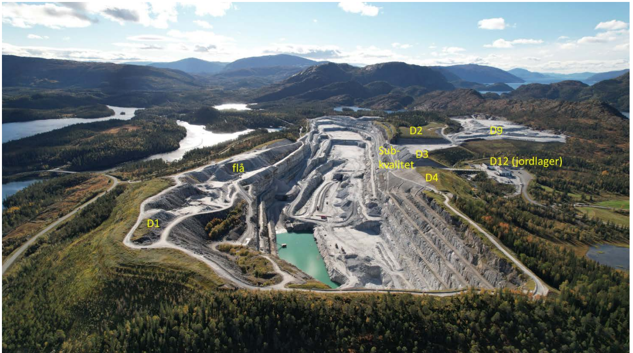
Figur 1 Flyfoto over dagbrudd og deponier (25. september 2022).
