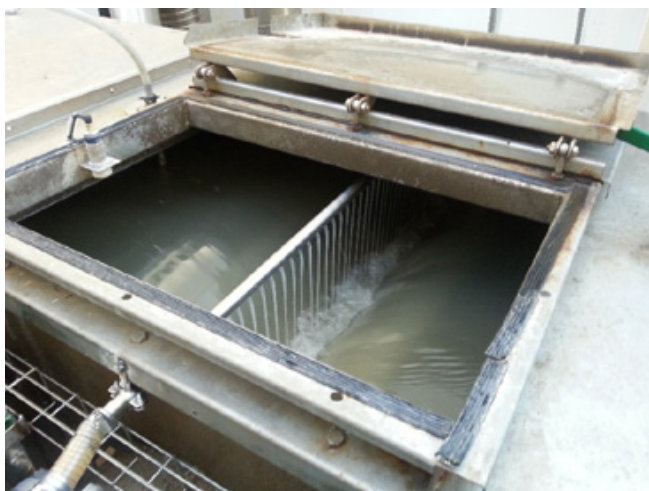
Bilde 4: Innblanding polymer ved Breivika RA 2014
