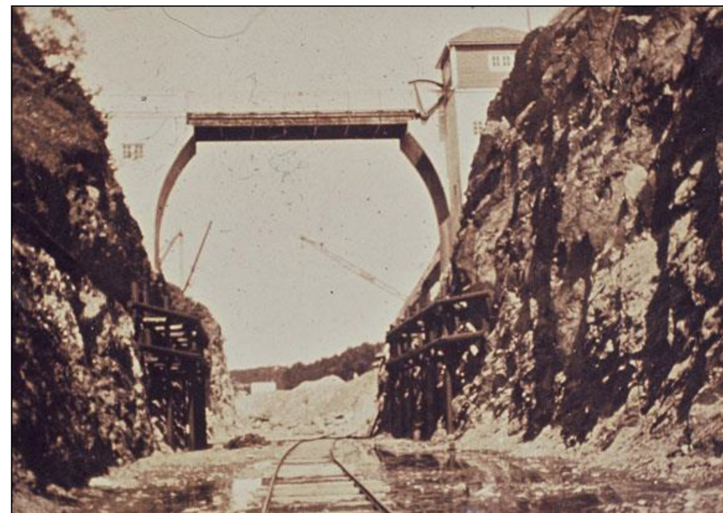
Figur 52; Ny vippebru vart bygd, med utviding av kanalen i perioden 1927-35.
