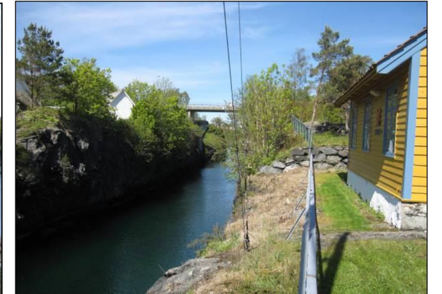
Figur 51; Telegrafstasjonen til høgre. Det gamle brukaret ser ein under den nye brua.
