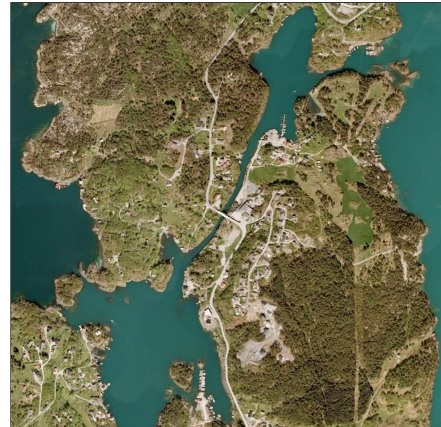
Figur 25; Kryssinga av kanalen i bru gjev krappe svingar på fylkesvegen.
