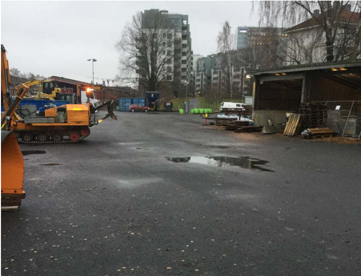
Figur 6 Bilde av området ved T-banesporet på en av undersøkelsesdagene. Boreriggen sees til venstre i bildet.
