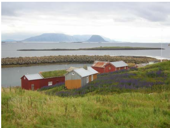
I Skjærvær har man kommet langt i arbeidet med bygningsvern.
