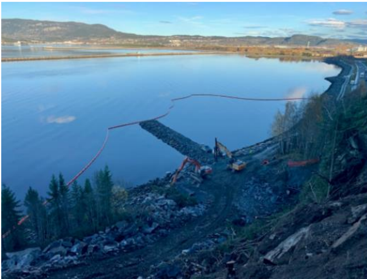
Figur 15 Prosjektets siltgardin plassert rundt området som ble fylt ut og ferdigstilt høsten 2020 (Foto: Acciona Construction).
