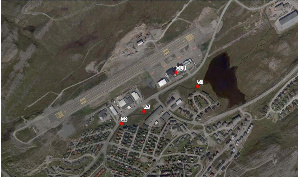
Figur 1: Prøvepunkter for miljøovervåkning ved Hammerfest lufthavn.
