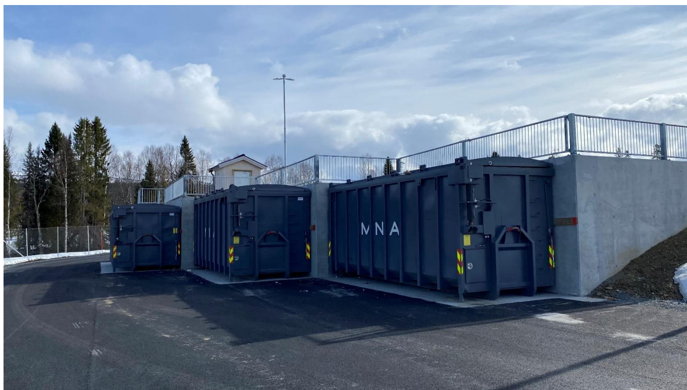
Containere ved omlastingsstasjonen. 1 til restavfall, 1 til fiber/ plast og 1 til matavfall. Lokk og grind åpnes ved fylling fra renovasjonsbil.
