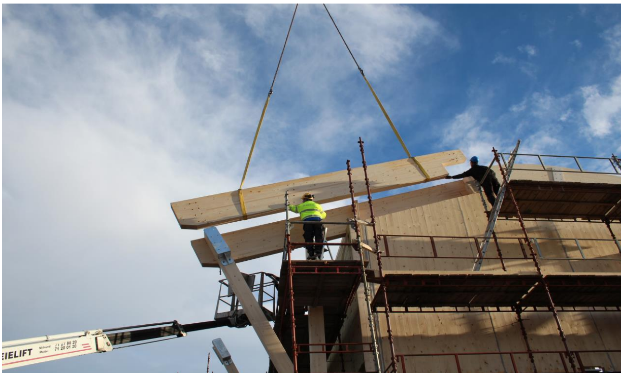
Bilde 9. Massivtre under montering på Årø lufthavn, Avinor, Molde i Møre og Romsdal.
