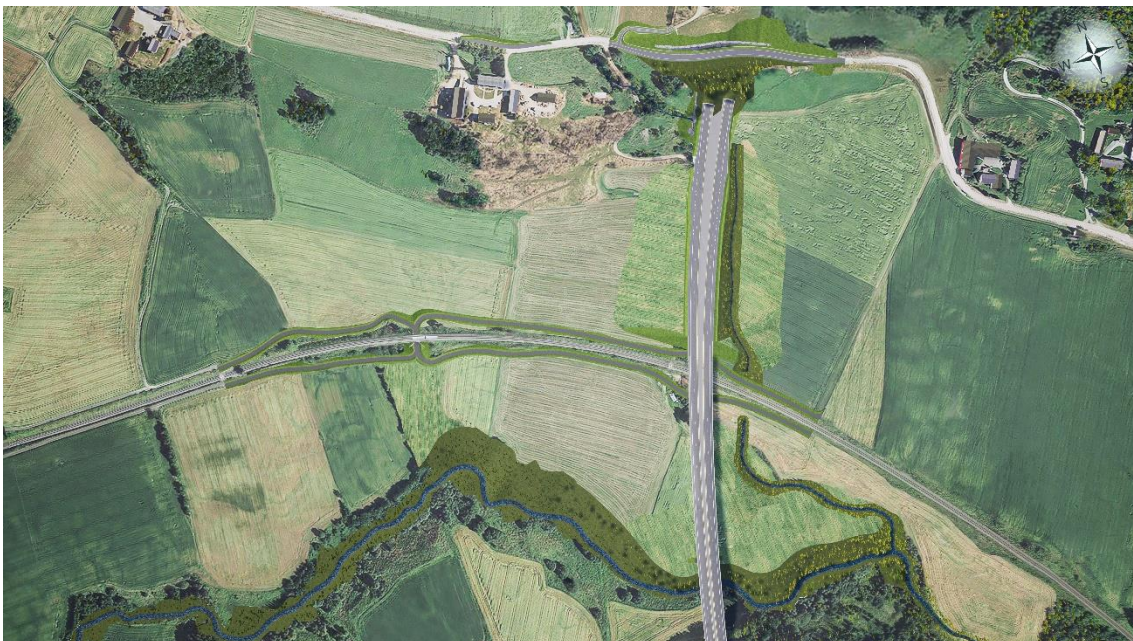
Figur 28: Ny trasé for Raudhåmmårbekken like øst for E6 på Holan.
