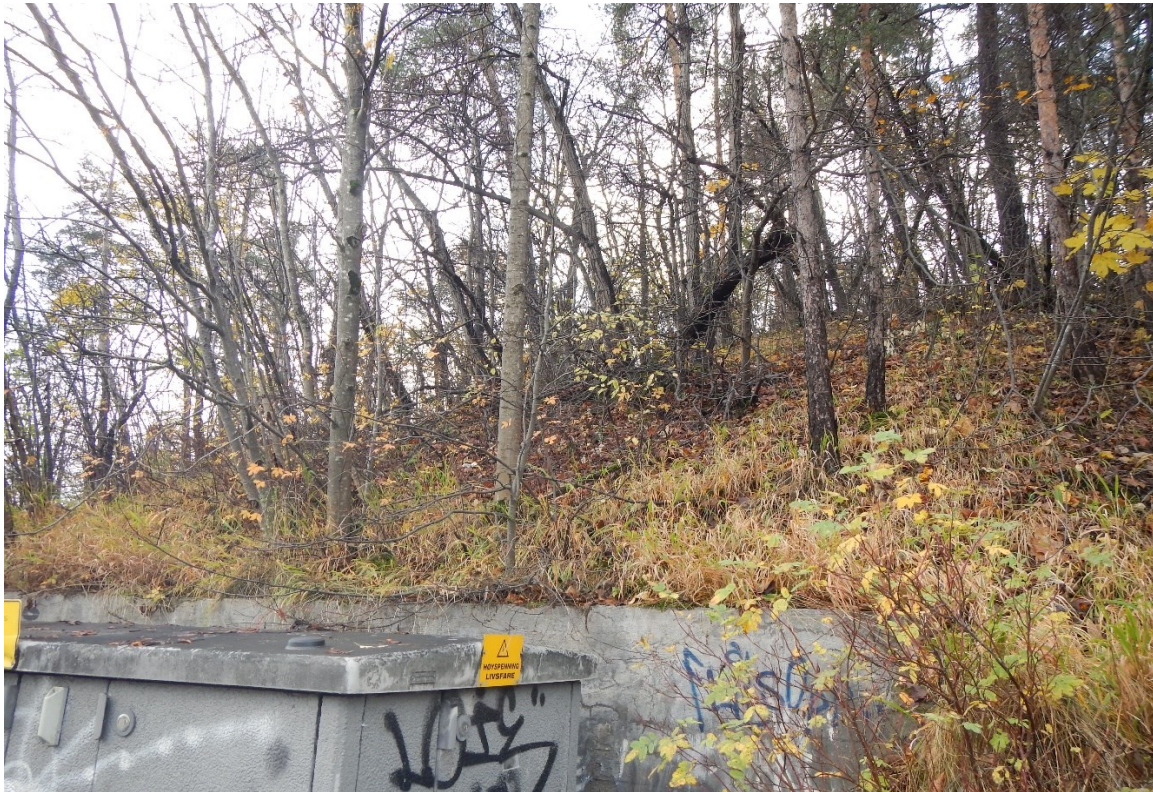
Figur 4. Kalklind-furuskogen sett fra gangvei, med langsmal, liten trafo + forstøtningsmur (foto: TEB).
