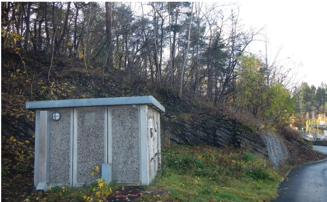
Figur 1. Nordkanten av Dronningberget NR. Nordvestre rygg med kalklind-furuskog sees bak (vest for) stor, firkantet trafo-stasjon. Nordenden av denne ryggen (helt t.h. i bildet) blir direkte berørt av utvidelse av gangvei (foto: TEB).
