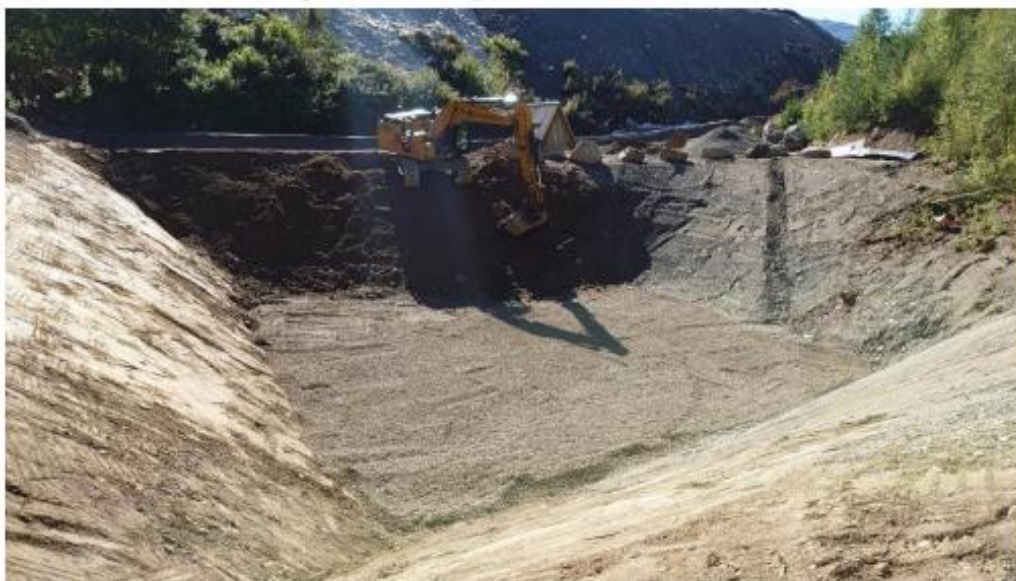
Figur 10 Bilde fra utvidelsen av infiltrasjonslagune utført i september 2020 (Foto: Asplan Viak)
