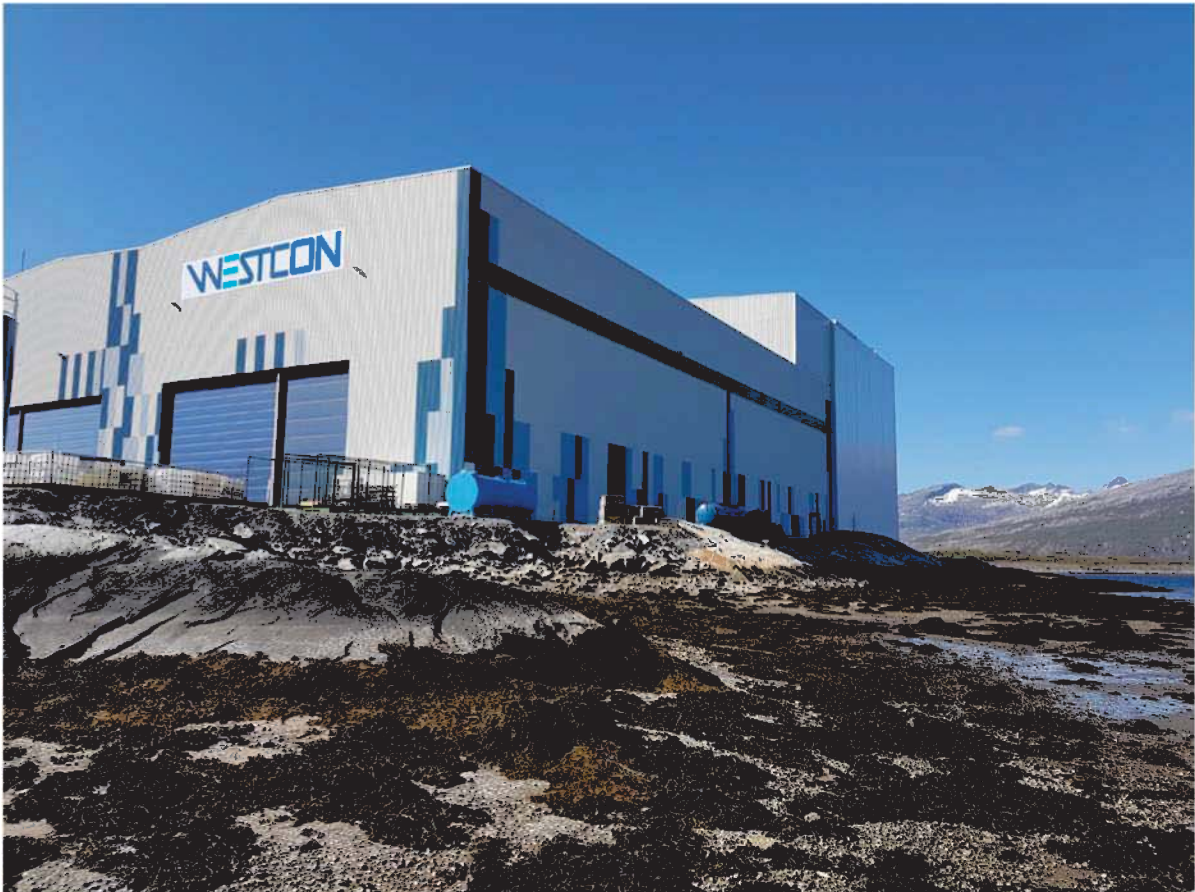
Figur 3-2. Bildet viser østsiden av Westcon hvor det er ønsket å fylle ut og utvide industriområdet noe.
