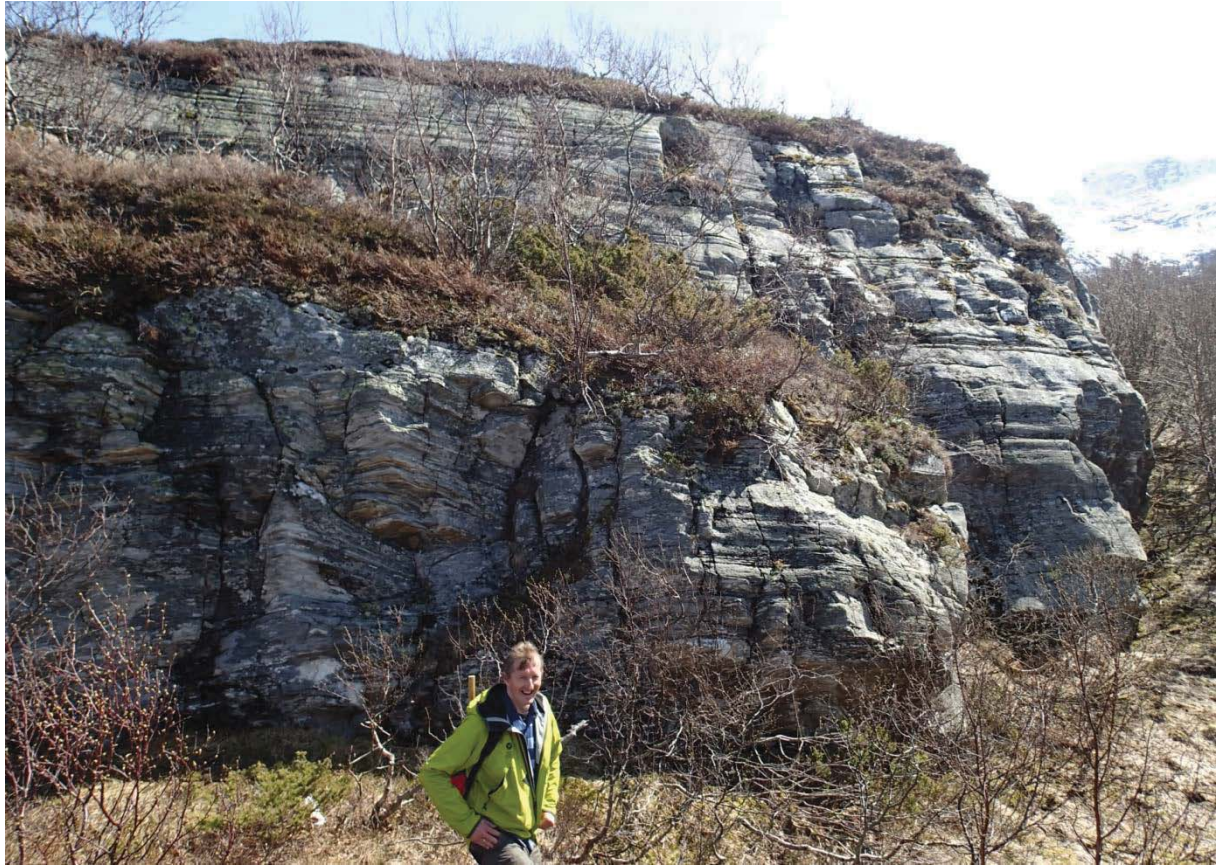
Fig. 16: Fjellveggen i den sørvestlige delen av området nær strandlinjen. Synlig er de vertikale sprekkene som kutter båndene av granittisk gneis og skape naturlige blokker av variabel størrelse. Bilde mot sør-øst.
