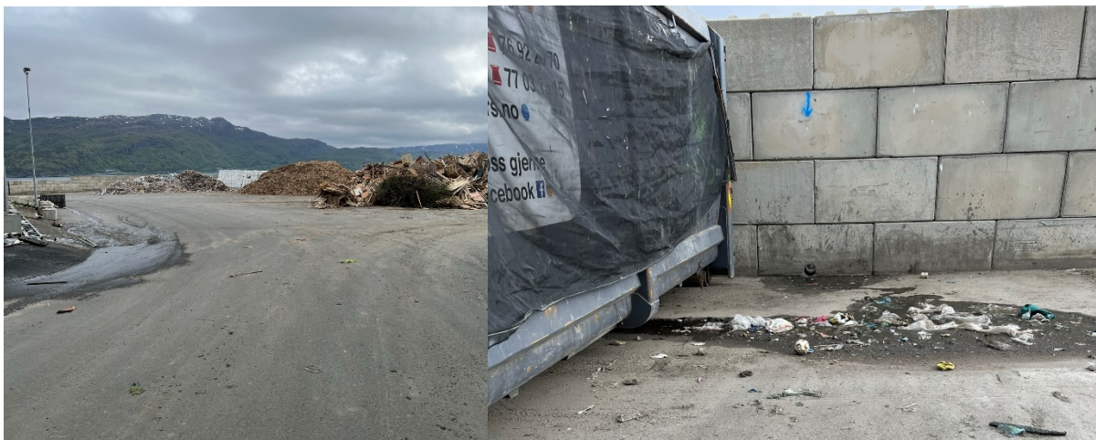
Figur 2: Bildet til venstre viser avfallet som er lagret på området øst på anlegget, mens bildet til høyre viser utslippspunktet for overvann fra område med krav til tett dekke øst på anlegget.
