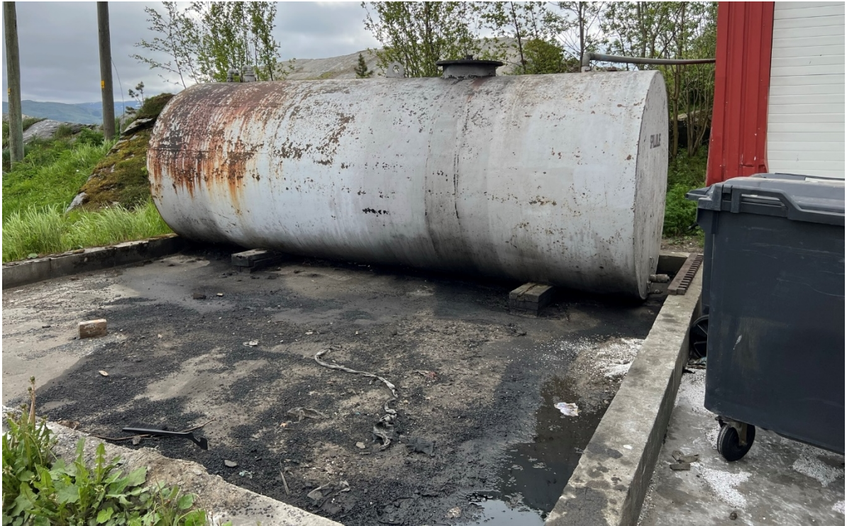
Figur 1: Viser spilloljetank med oppsamlingsarrangement.
