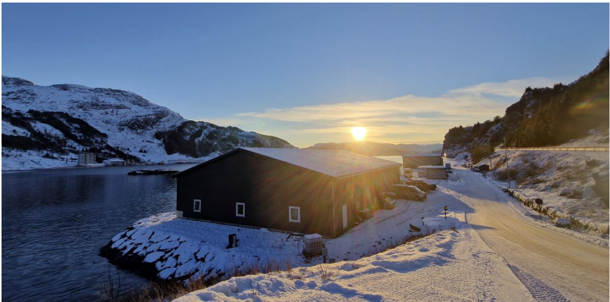
Figur 6-1 Eksisterende fylling med et mindre næringsområde, fra befaring 12.12.22
