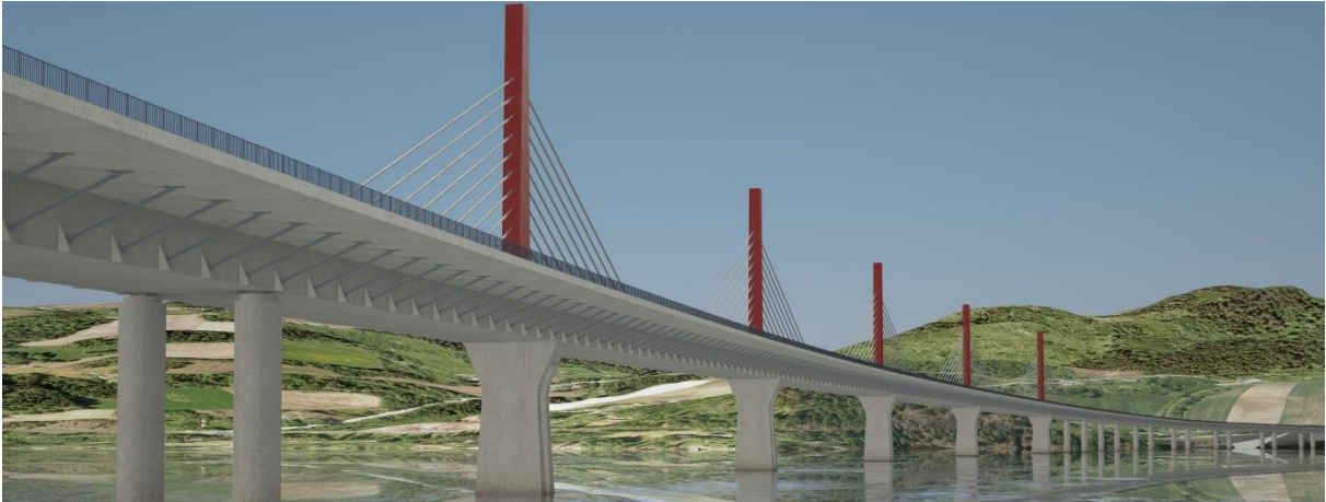
Figur 4-2: Eksempel på utforming av betongbru
