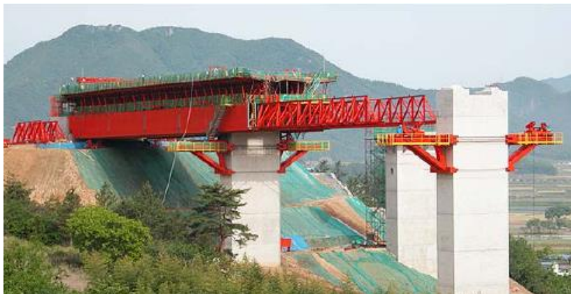
Figur 4-10: Eksempel på bruk av forskalingsvogn for bygging av overbygningen
