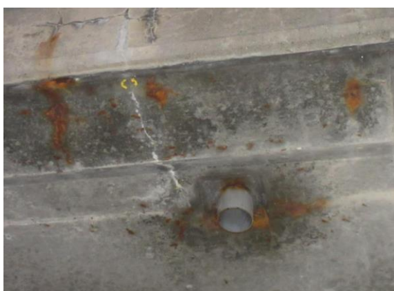
Figur 6-5 Typisk skader ved sluk. Kilde: Multiconsult for Nye Veier
