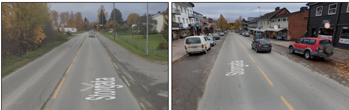
Figur 3-26: Fv. 213 gjennom Moelv. Kilde: Google maps
