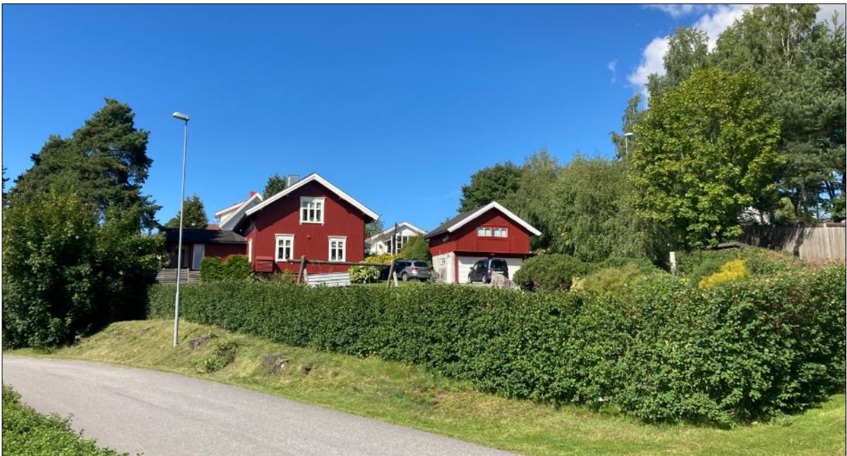
Figur 5-11: Strandvegen 22, den tidligere husmannsplassen "Engebretstuen", som vil rives ved bygging av alternativ 1. Kilde: COWI AS
