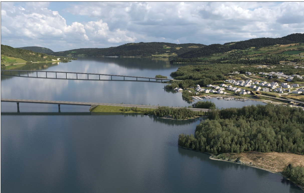
Figur 5-18: Alternativet sett i retning nord. Ny vei i forgrunnen og eksisterende vei i bakgrunnen. Kilde: COWI
