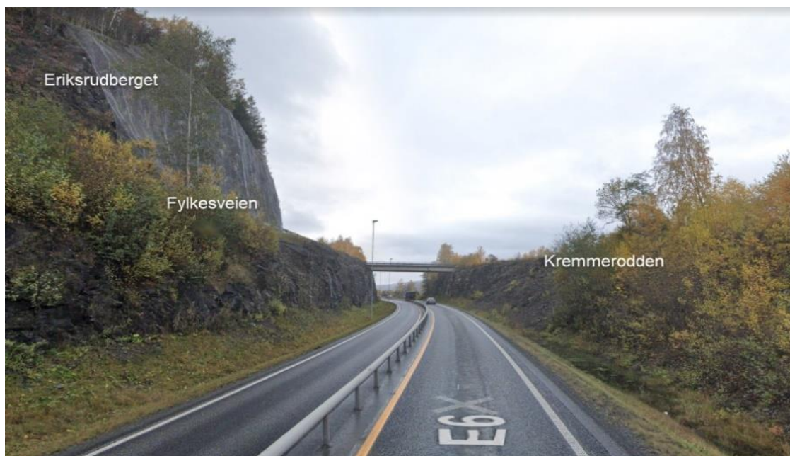
Figur 10-2 Dagens E6, sett nordover. Kremmerodden til høyre og Eriksrudberget til venstre. Fylkesveien ligger langs Eriksrudberget, høyere enn dagens E6. Kilde: Google Streetview
