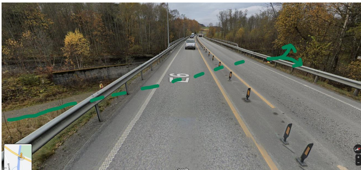
Figur 12-7 Kryssing for tursti under E6 i dag, sett mot nordvest. Kilde: Google Streetview / COWI AS
