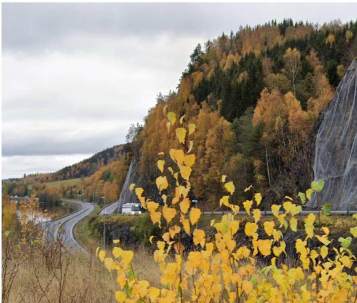
Figur 10-5 Dagens E6 og fv. 2538 sett sørover fra Kremmerodden. Eriksrudberget til høyre. Kilde Google Streetview
