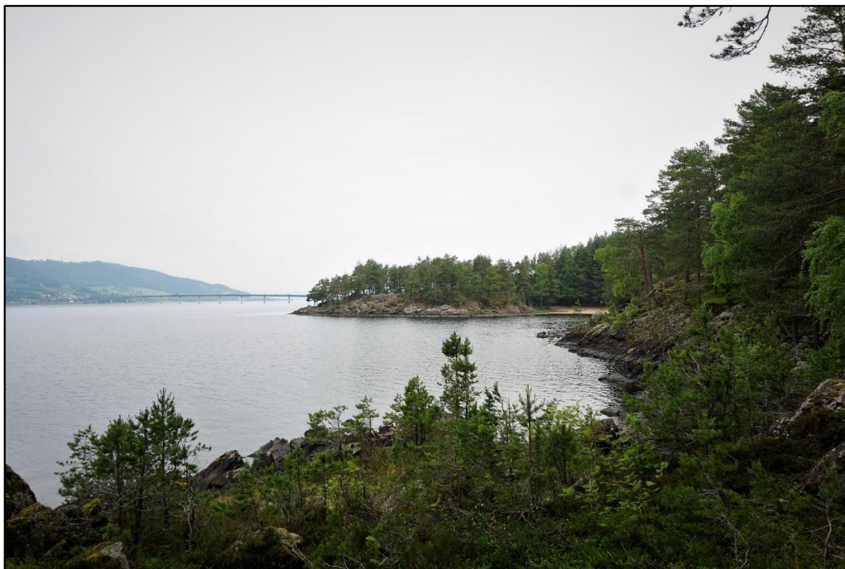
Figur 3-2: Utsyn mot Møkkvika fra sør ved turstien som går fra Steinvik opp til Moelv småbåthavn. Dagens Mjøsbru i bakgrunnen. Kilde: COWI AS.
