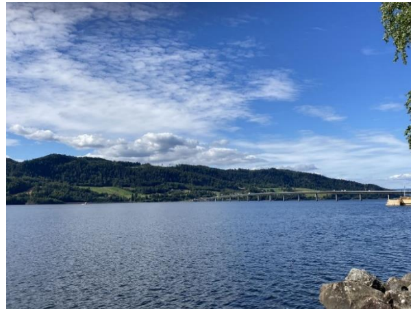
Figur 5-4: Eksisterende Mjøsbru. Kilde: COWI.
