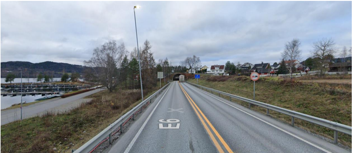
Figur 5-13. Moelvtunnelen i Moelv. Kilde: Google maps, november 2022.
