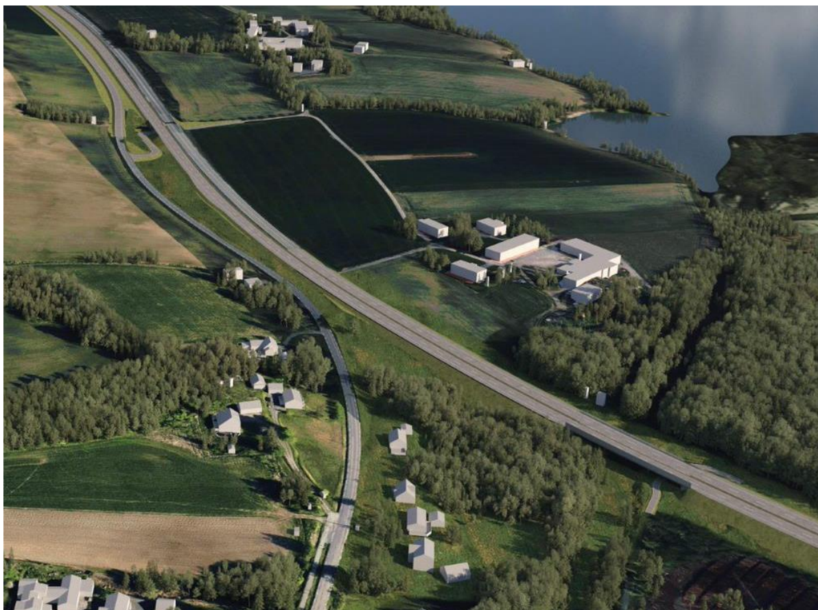
Figur 7-36: Vismunda bru til høyre og kulvert mot Svennes og Verket gård til venstre. Kilde: COWI AS
