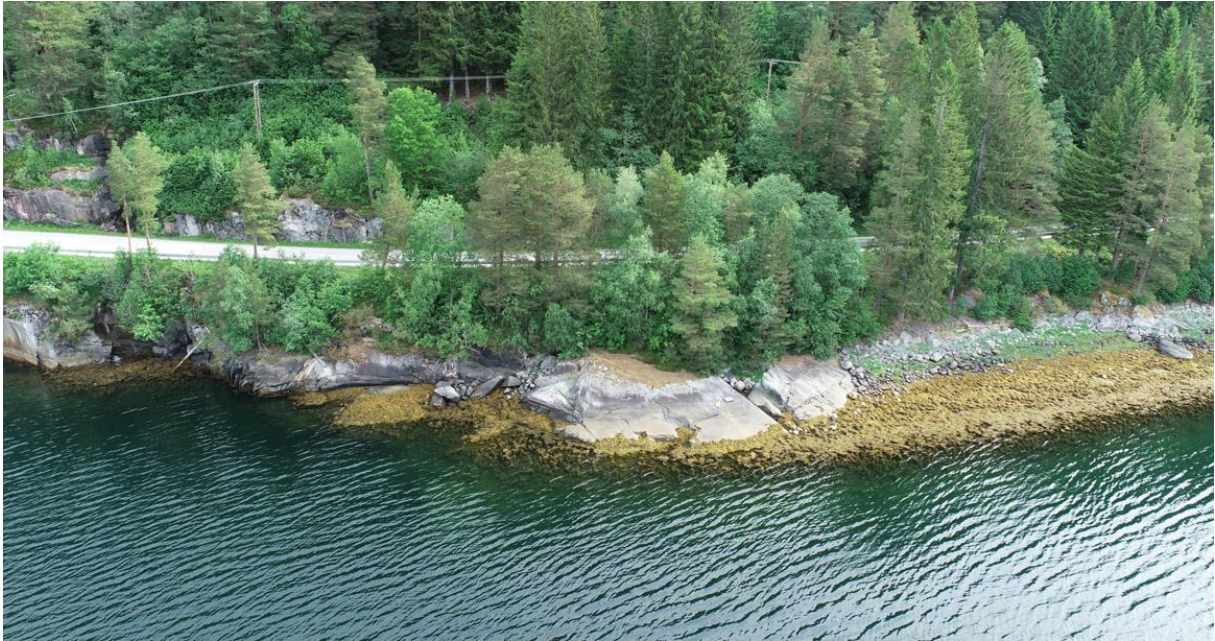
Figur 2.1 Dronebilde av planlagt plassering for kaihakk i Todalsfjorden, sett fra nordøst. Bildet viser berg i dagen.
