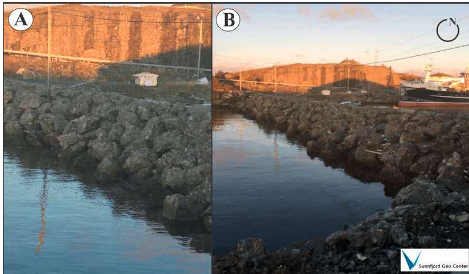
Figur 12: Bilda viser vegfyllinga mellom Nikøy i vest og Årebrottet. Bildet er tatt frå Årebrottet. Fyllinga er bygd opp av massar henta frå området. Blokkene som ligg langs fyllinga mot sør fungerer som eit vern mot bølgeaktivitet, og har størrelsar på rundt 1\text{m}^3 .
