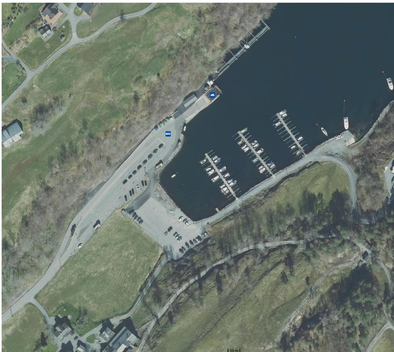
Figur 5-1: Flyfoto av Hatvik ferjeleie med nærliggende områder. Nord for veien og kaien er det en bratt fjellskråning. Kilde: finn.no.
