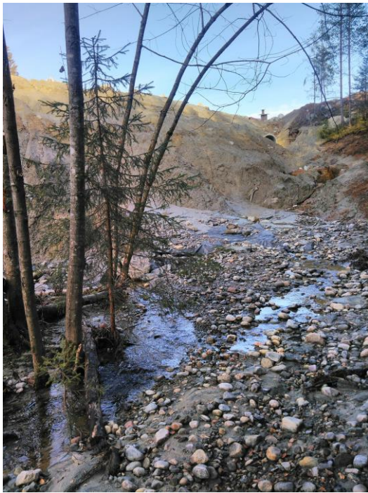
Eksempel på påvirkning som sorterer under urban utvikling. Gjenfylling av bekk med løsmasser på Gomsrud i Kongsberg i forbindelse med planering før boligutbygging. Bilde: I.Aasestad
