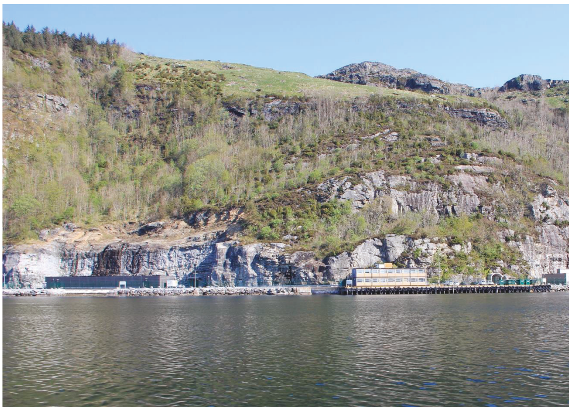
Figur 10 Eksisterende kjøleanlegg til venstre i bildet. Kontorbrakkerigg til høyre.
