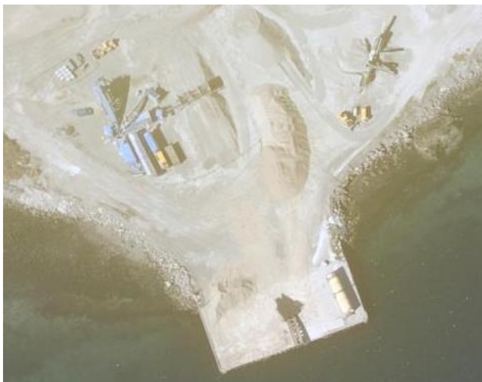
Figur 16. Historisk bilde fra 2007 som viser sorteringsverket på eiendommen.
