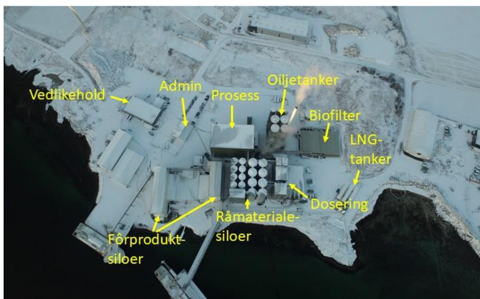
Figur 4 Oversiktsbilde av eksisterende anlegg. Bildekilde: Mowi Feed.
