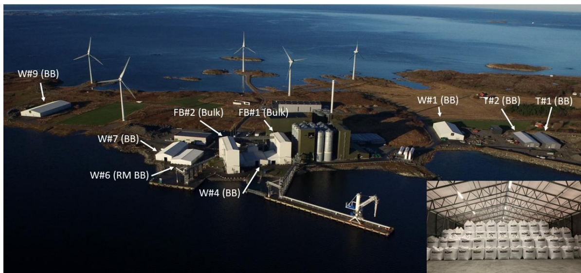
Figur 5 Oversiktsbilde av lagerbygg og siloer for ferdig fôrprodukt. Bildekilde: Mowi Feed.
