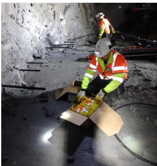
Foringsrør i borehull. Foto: Statens vegvesen
