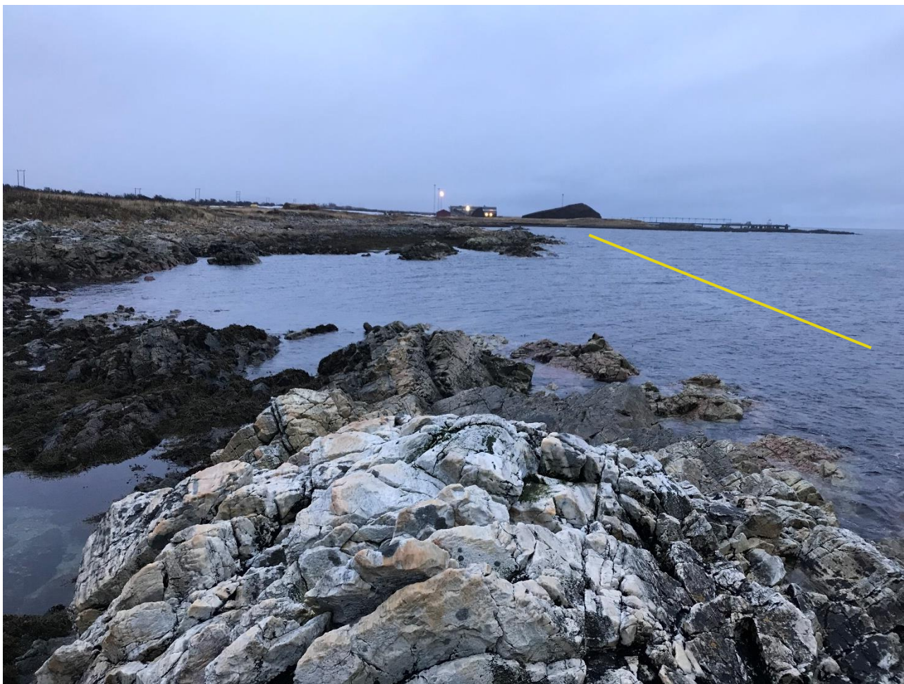
Figur 2 Bilde fra område for fylling. Bilde tatt mot nord. Gul linje markerer omtrentlig fyllingstopp som vist på vedlagt tegning G01.
