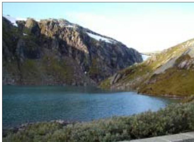
Blåvatnet har lenge vore regulert for å sikre prosessvatn til industrien i Odda. Vatnet har ein sentral posisjon i framlegget til kraftregulering av Eitrheim-/Tokheimsvassdraga, som for tida er til konsesjonshandsaming. Foto: Anniken Friis.
