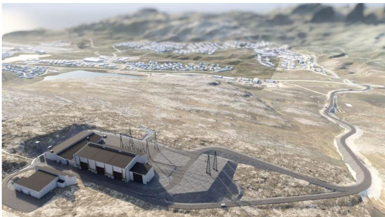
Figur 2-5: Viser trafo området ved Hyggevatn etter utbygging med eksisterende trafostasjon og adkomst fra fv. 8124.
