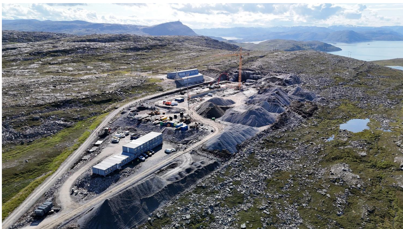
Figur 2-3: Anleggsområdet ved Hyggevatn per september 2025 (Kilde: Statnett 2025). Eksisterende trafostasjon og adkomstveg til Lucerna, midlertidig masselager og etablerte intern anleggsveger og riggfasiliteter for bygging av den nye transformatorstasjonen. Per dags dato er det meste av massene benyttet for opparbeidelse av tomta, og de nye transformatorstasjonene til Statnett og Equinor som er under oppføring.
