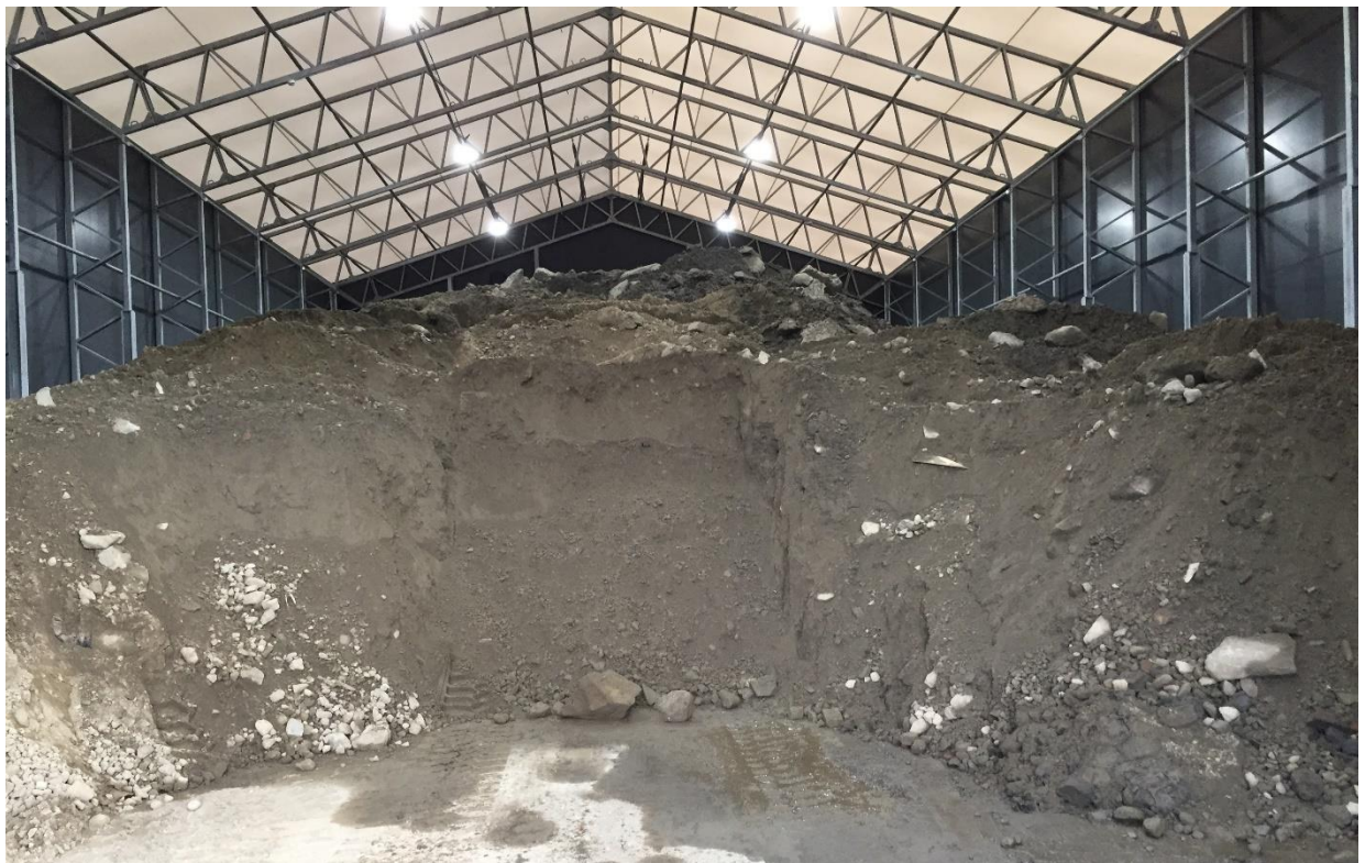
Figur 5 Bilde som viser mellomlagrede masser inne i telt/hall, Laksevågneset (Foto: Rimol Miljøpark)
