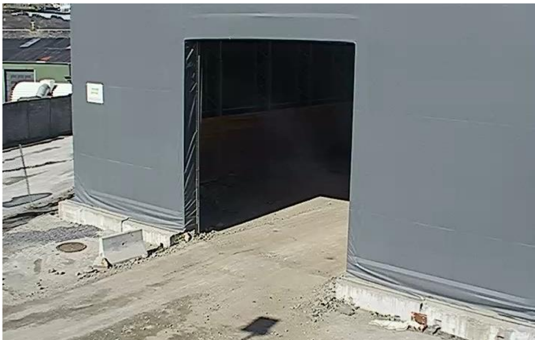
Figur 4 Bilde som viser innkjøring til telt/hall, Laksevågneset (Foto: Rimol Miljøpark)
