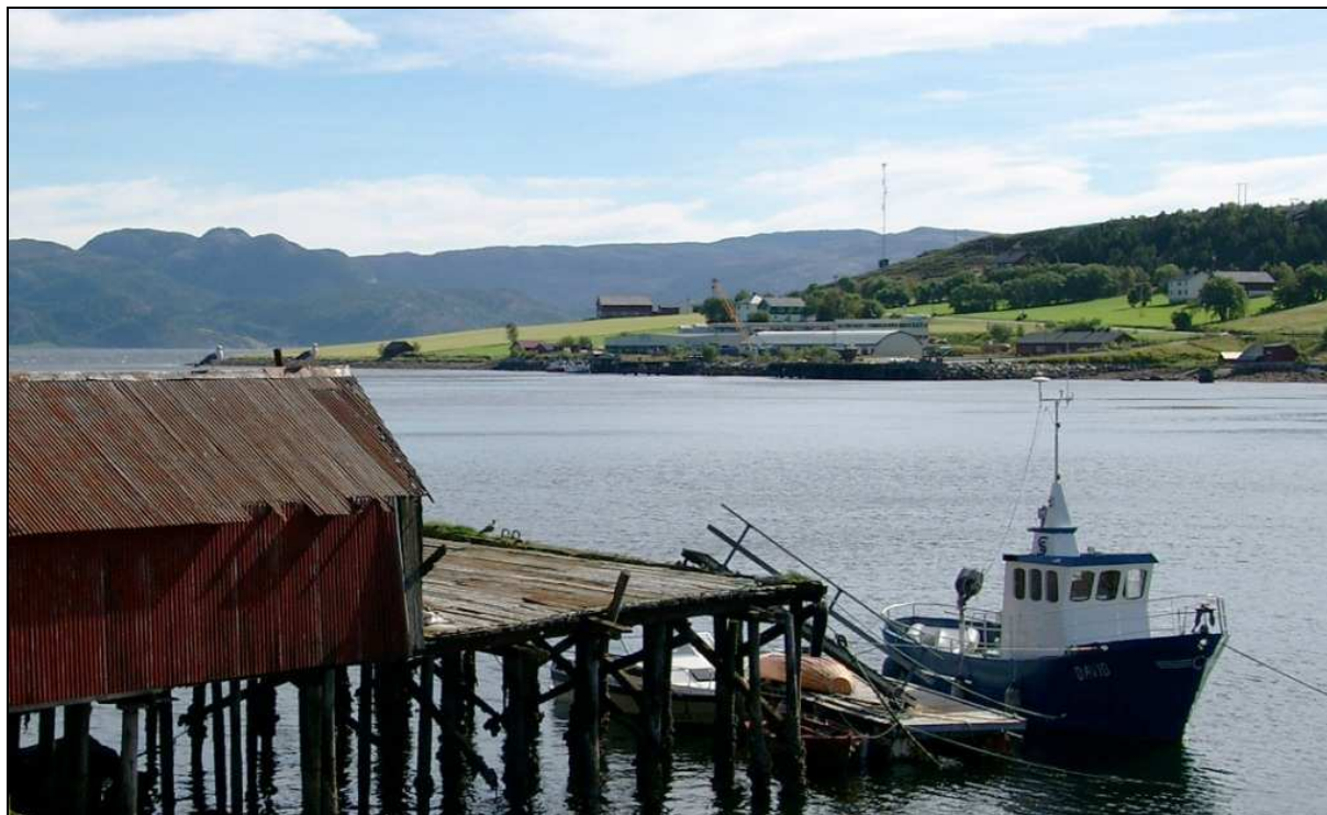
Figur 27. Den gamle kaien på Selva er i dag i dårlig forfatning, det samme gjelder skuret som står her. Like bortenfor står dessuten en gammel brygge. På andre siden av bukta sees de tradisjonelle gårdsmiljøene på Selvneset. Det er bygd ut en del næringsareal i bukta, noe som gjør at det helhetlige preget brytes.
