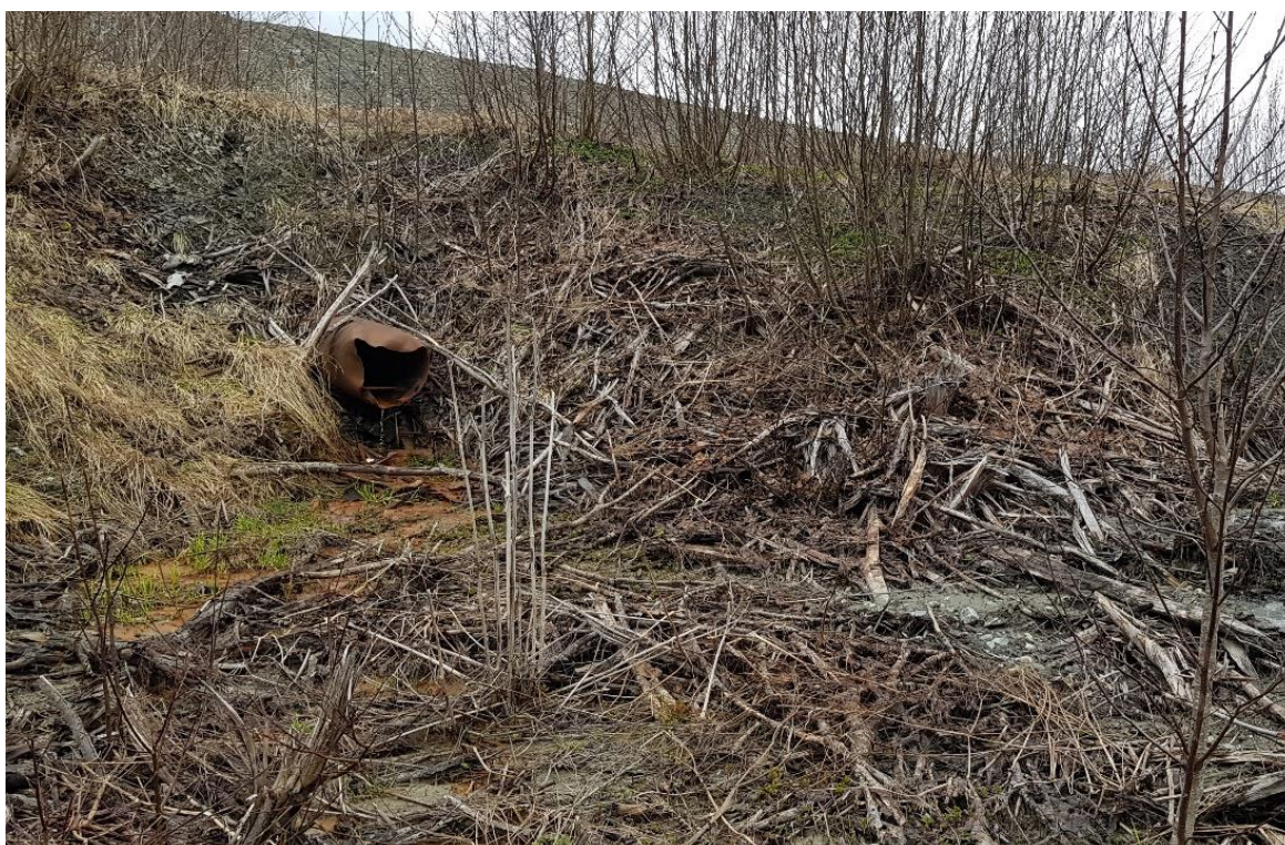
Figur 5.1 Bildet av sigevannsrøret til Tiller løsmassedeponi/snødeponi.
