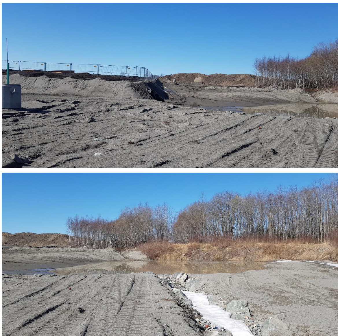
Figur 4.2 Øverst en oversikt over deponiet sett fra nordøst med sedimentasjonsbassenget i forkant. Nederst sedimentasjonsbassenget med overløpsbekk. Bekken er steinsatt og på bildet delvis dekt av snø.
