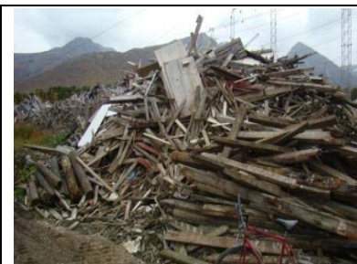
Trevirke som mellomlagres.
