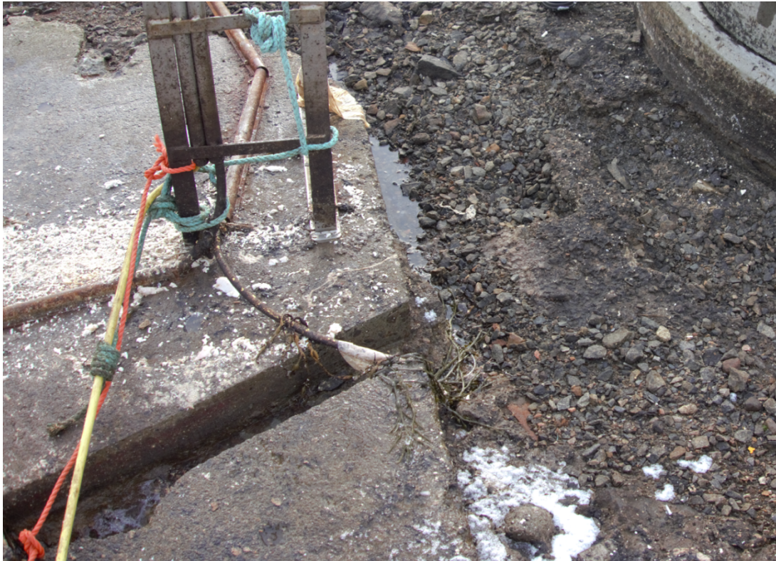
Figur 1. Utløp av renne for oppsamling av spylevann. (Foto: Statsforvalteren i Nordland)
