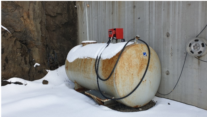
Figur 2. Lagertank for diesel. (Foto: Statsforvalteren i Nordland)
