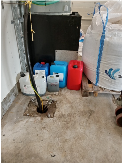
Figur 2 Farlig avfall uten tilstrekkelig merking og uten sikring mot lekkasje direkte til ytre miljø.
